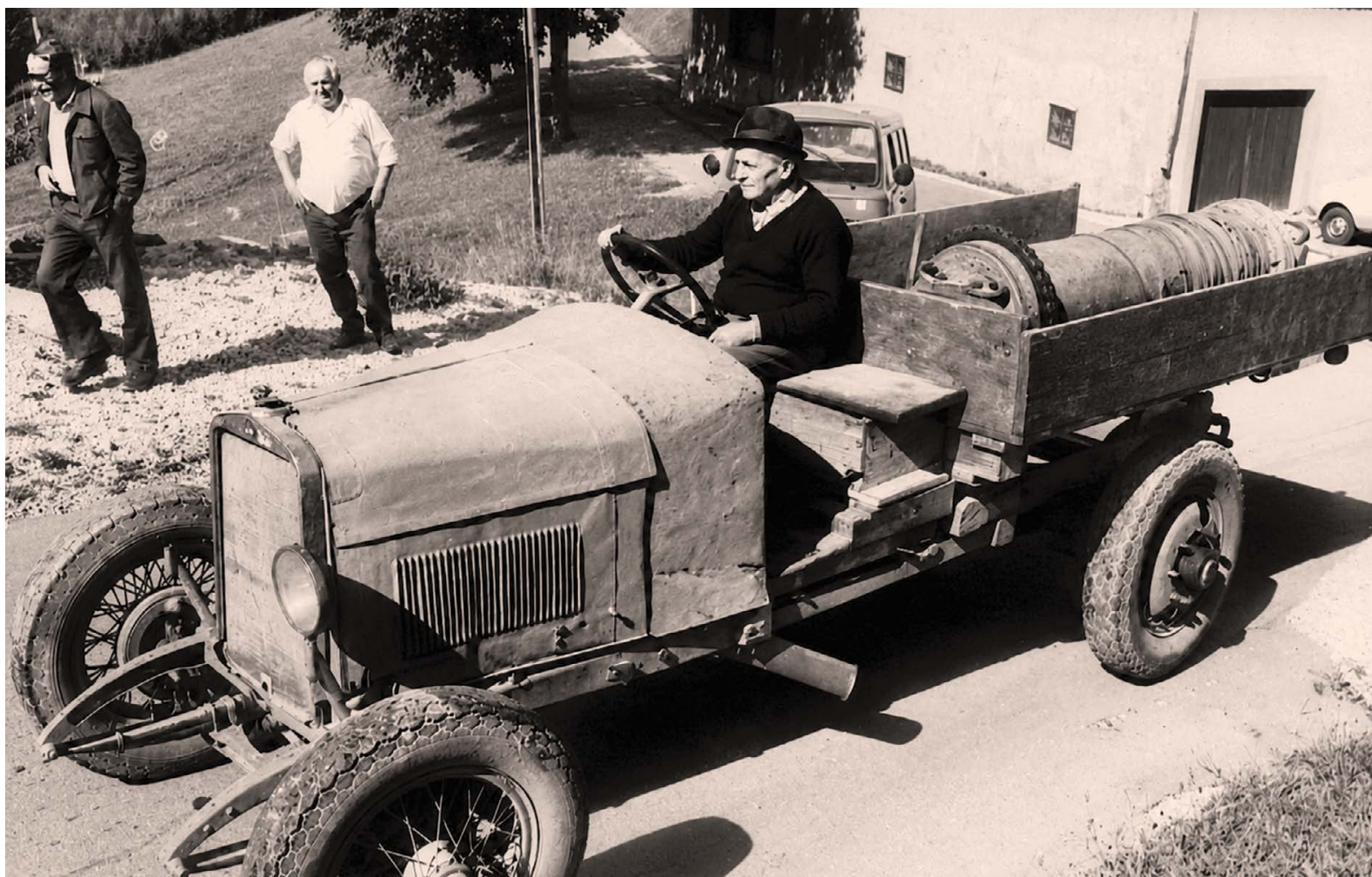
Štefan Gnezda na svojem žičnem žerjavu iz l. 1932 (fotografija I. Smolej iz l. 1988): slika vitla na predelanem in prilagojenem osebem vozilu SPA (Torino) iz l. 1925. / Fotografijo hrani Gozdarski inštitut Slovenije - Oddelek za gozdno tehniko in ekonomiko.
